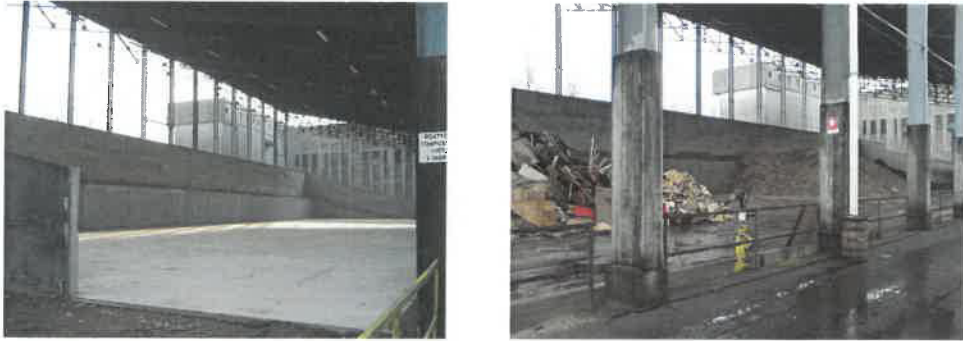
Area per la triturazione del legno trattato
