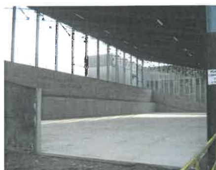
Area per la triturazione del legno trattato
