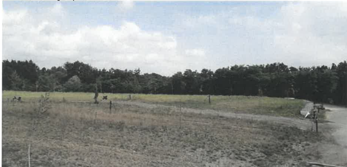
Discarica Barengo - post chiusura
