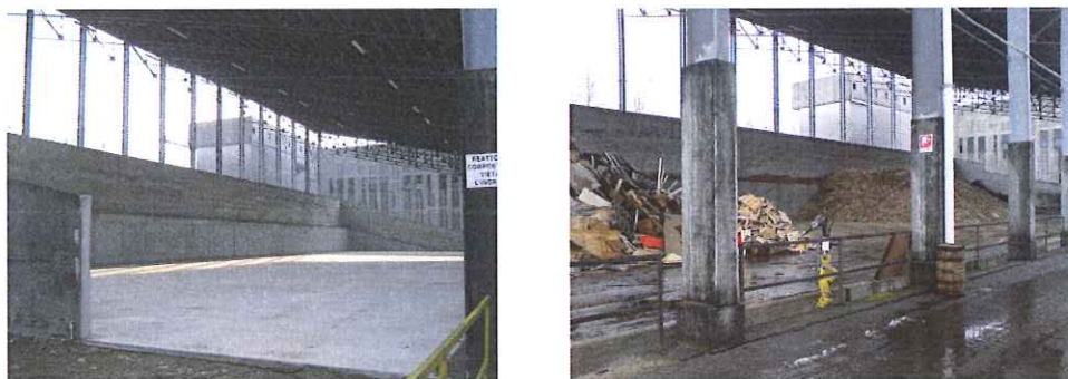
Area per la triturazione del legno trattato
