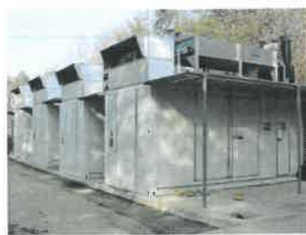
Impianto di recupero energetico biogas
