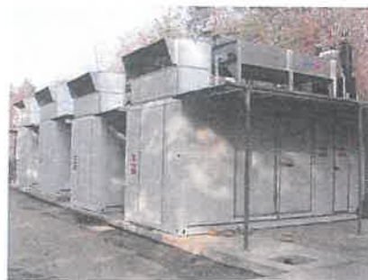
Impianto di recupero energetico biogas
