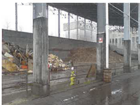
Area per la triturazione del legno trattato
