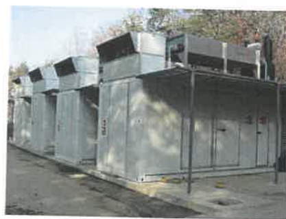
Impianto di recupero energetico biogas
